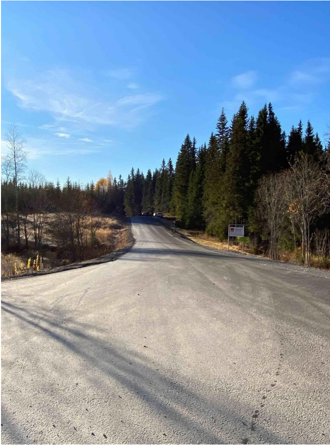
Bilde 5: Viser asfaltert internvei frem til Lillehammer Pukkverk og planlagt massemttak på Vesleseterenga. (Foto: Areal*)
